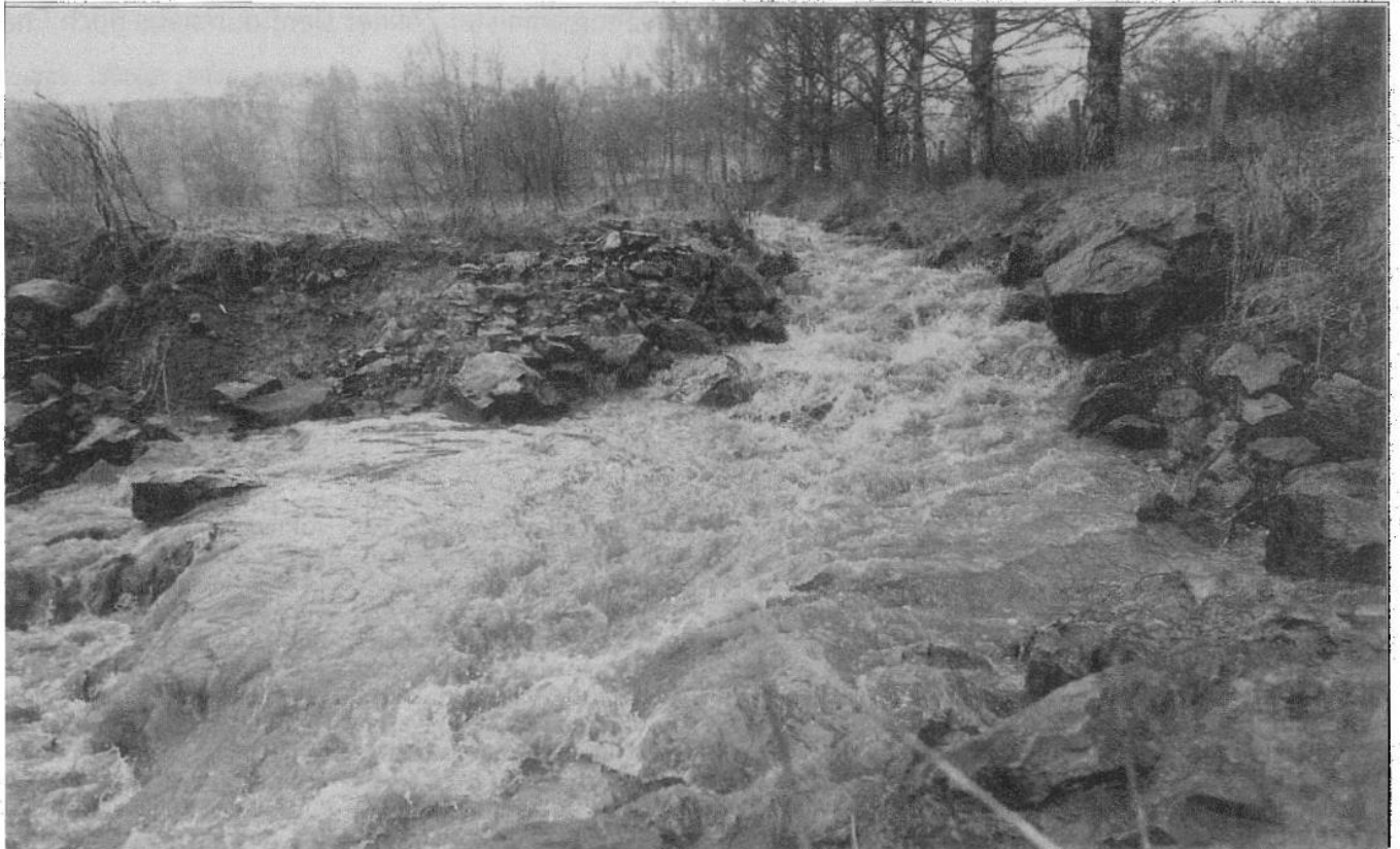
Nach einem Regenguss vor wenigen Tagen: Der ansonsten trockene Graben zwischen dem Rückhaltebecken am Thalhausener Weiher und dem Burbach hat sich in einen reißenden Bachlauf verwandelt. ■ Foto: Bastian Pollmann
